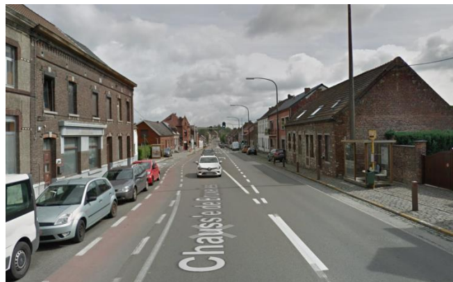
Figure 29 : Traversée du village par la N6
