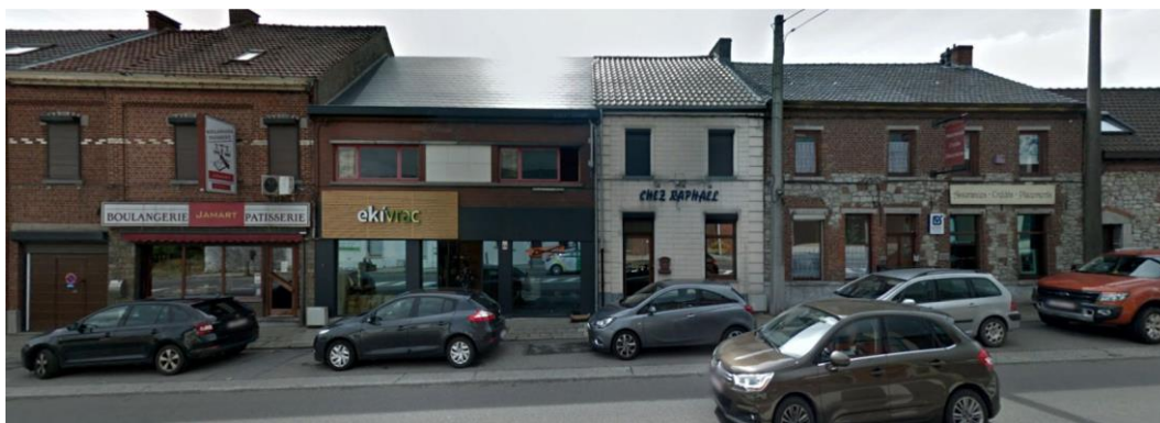
Figure 30 : Exemples de bâtiments à vocation commerciales le long de la N6
