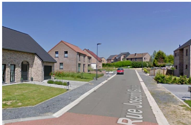
Figure 50 : Nouveau quartier (années 2000) au Nord du centre historique Source : Google Streetview (2009)
